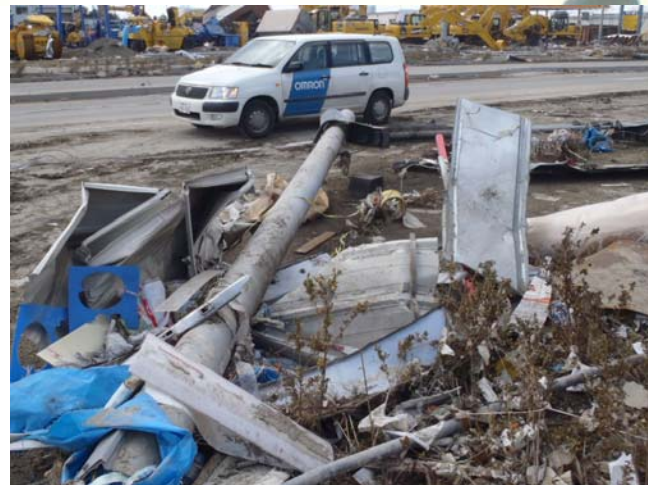
交通信号機の復旧作業 (オムロンフィールドエンジニアリング)
